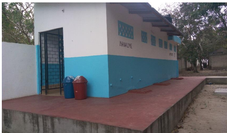
Aussenansicht Sanitäre Anlagen nach Renovierung
